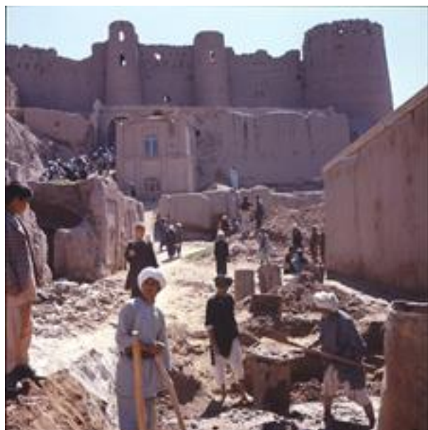
Ciudadela de Ikhtyarrudin, restaurada por la UNESCO de 1974 a 1980, revitalizando las técnicas tradicionales y la utilización de materiales tradicionales. © Flemming Aalund.
